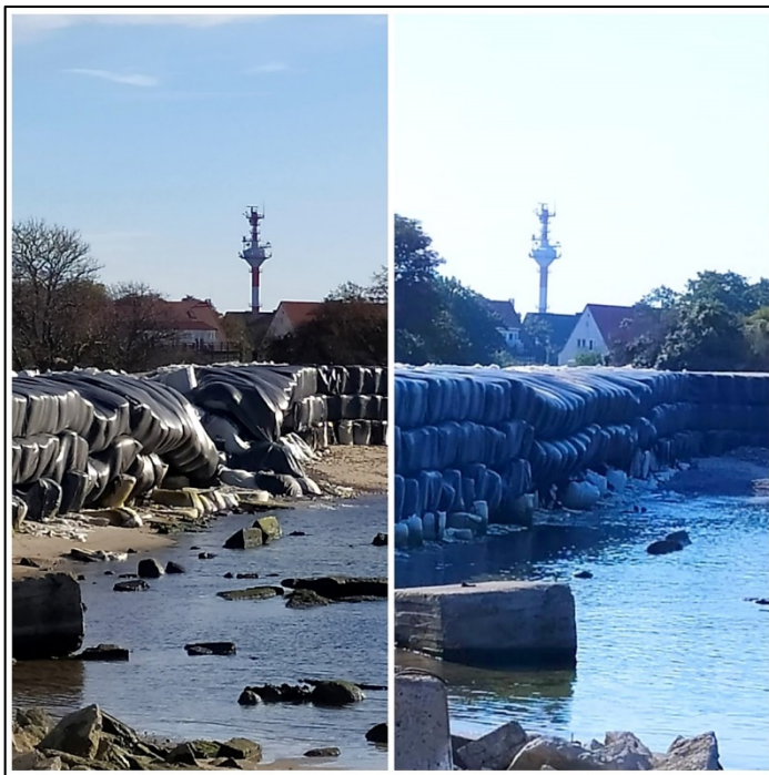
Рис. 4. Биг-бэги на территории пос. Коса со стороны моря: слева — 2 ноября 2023 г., справа — 16 августа 2023 г.
